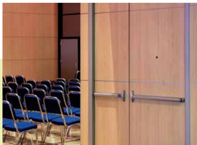
Un dettaglio della maniglia antipanico Detail of anti-panic push bar
